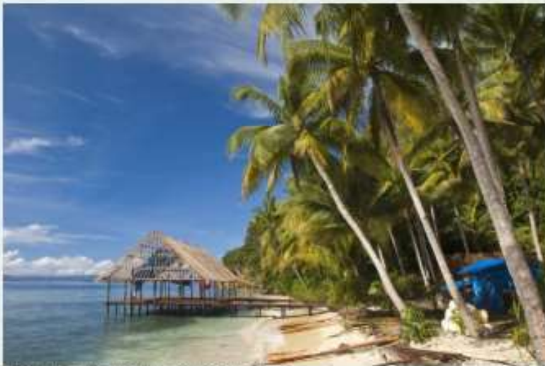
Einer der Bungalows während der Bauarbeiten.
